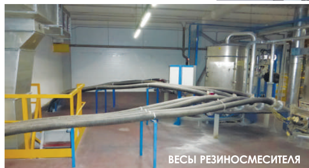
ВАКУУМНЫЙ НАСОС ПНЕВМОТРАНСПОРТА, ПОДКЛЮЧАЕМЫЙ К ФИЛЬТРУ ВЕСОВ
